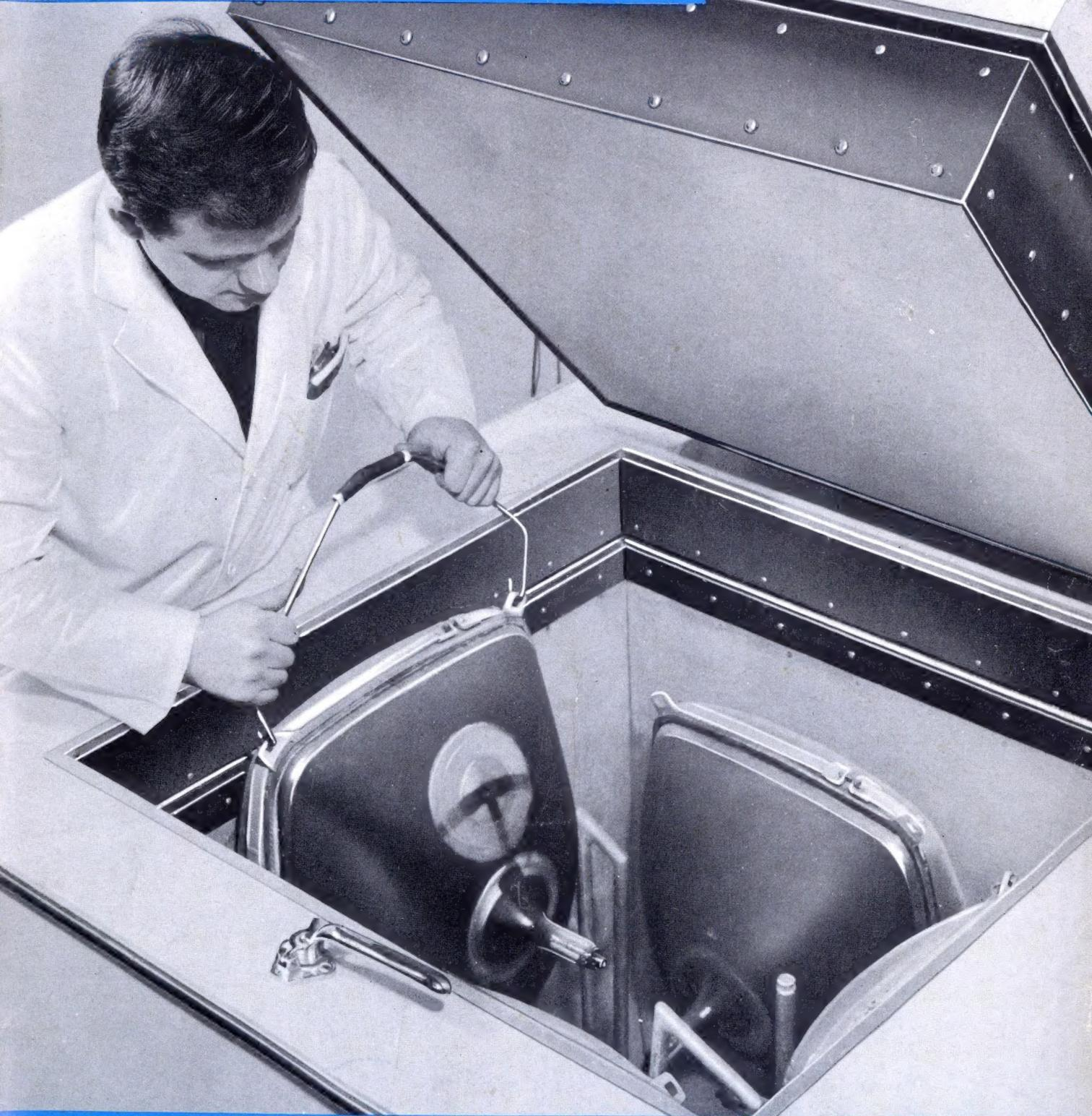
**Die Zuverlässigkeit der neuen Fernseh-Bildröhren ohne Schutzscheibe wird durch zahlreiche Untersuchungen gewährleistet.**
